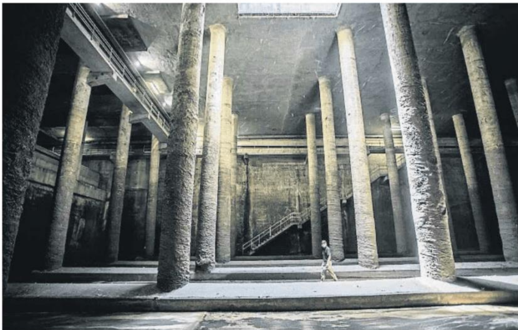
El depósito del parque Joan Miró. con una capacidad de 55.000 metros cúbicos
